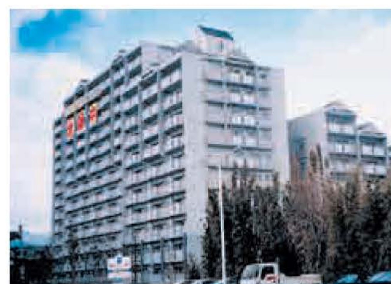
震源地付近でプライススリーブを採用した マンション(’95.2.17撮影)
